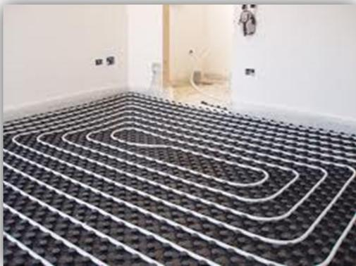
e acqua, vaso di espansione chiuso, pompa di circolazione) e controllata da cronotermostato ambiente. Impianto in tubo multistrato prodotto o similare posato su pannello in polistirene espanso sinterizzato UNI 7819 a ritardata propagazione di fiamma (classe 1 di reazione al fuoco) di idoneo spessore ed annegato in idoneo massetto in cls, comprensivo di collettore di distribuzione modulare, valvole di
