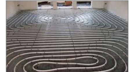
**Figura 16** Riscaldamento/raffrescamento a pavimento.
